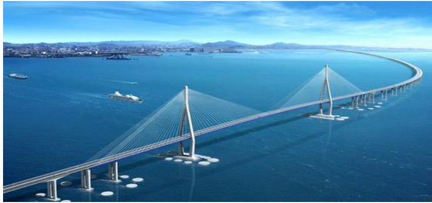
Hình 3. Cầu dây văng Incheon, Hàn Quốc
